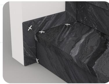
Una vez colocados el peldaño y la tabica, procederemos con la colocación de los zanquines. Alrededor del zanquin siempre debe respetarse una junta mínima de 3 mm.
