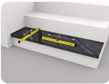
Durante la colocación y antes del fraguado del adhesivo, es muy importante comprobar los niveles de planimetría de eje X e Y. Esta operación se tendrá que hacer en todos los peldaños, por si hay que hacer alguna pequeña corrección.
