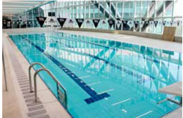
Instalación deportiva / Sport facilities Sistema / System Ga Spa U
