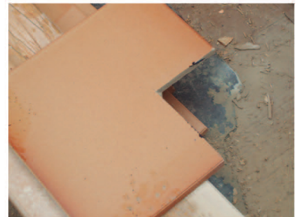
Fig. 1-Método de corte, con corte todo el espesor a la vez, avance lento, con el que no se rompen las baldosas.
