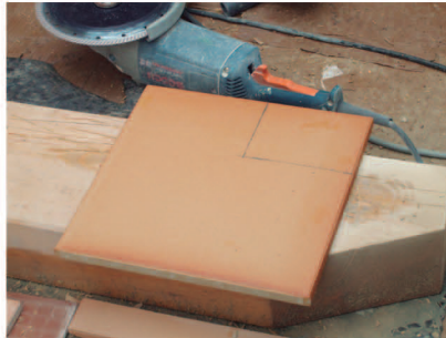
Fig. 1-Método de corte, con corte todo el espesor a la vez, avance lento, con el que no se rompen las baldosas.
