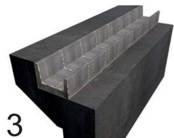
3 Colocación y alineación de la primera hilada de piezas, llaneando con material el perfil de unión y eliminando el sobrante con una espátula, así colocamos y rejuntamos a la vez.
